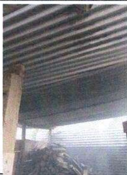
Foto 5: Sustrucción de lámina, por lamina troquelada aluzinc calibre 26 en cocina, Sustrucción de elementos de fijación en cocina. Sustrucción de estructura de soporte de madera, por metal en cocina
