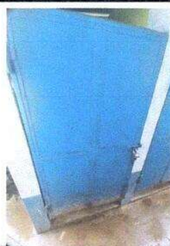
Foto 4: Mantenimiento a estructura (lijado, cepillado, sujeciones, aplicación de pintura)
