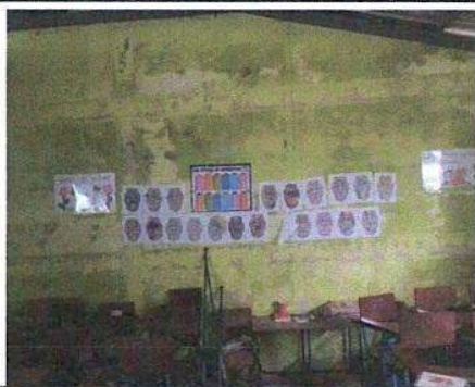
Foto 3: Pintura en muros exteriores e interiores
