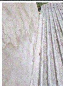
Foto 2: Sustrucción de lamina, por lamina troquelada aluzinc calibre 26 de aulas, Sustrucción de capote de lámina para lámina troquelada de aulas
